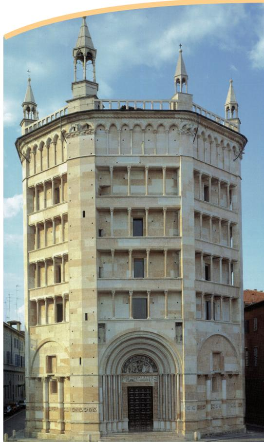
Il battistero è un edificio cristiano a pianta centrale (circolare o poligonale) che ebbe origine da un modello romano «profano», l'edificio a pianta centrale delle terme romane, contenente le vasche per l'acqua. L'architettura termale opportunamente reinterpretata e rielaborata era l'ideale per il rito del battesimo, che avveniva infatti per immersione.
